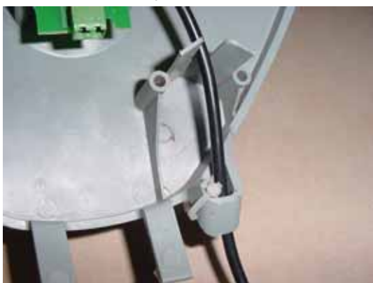
Bild 1.18 Införande av elkabeln i kåpan
